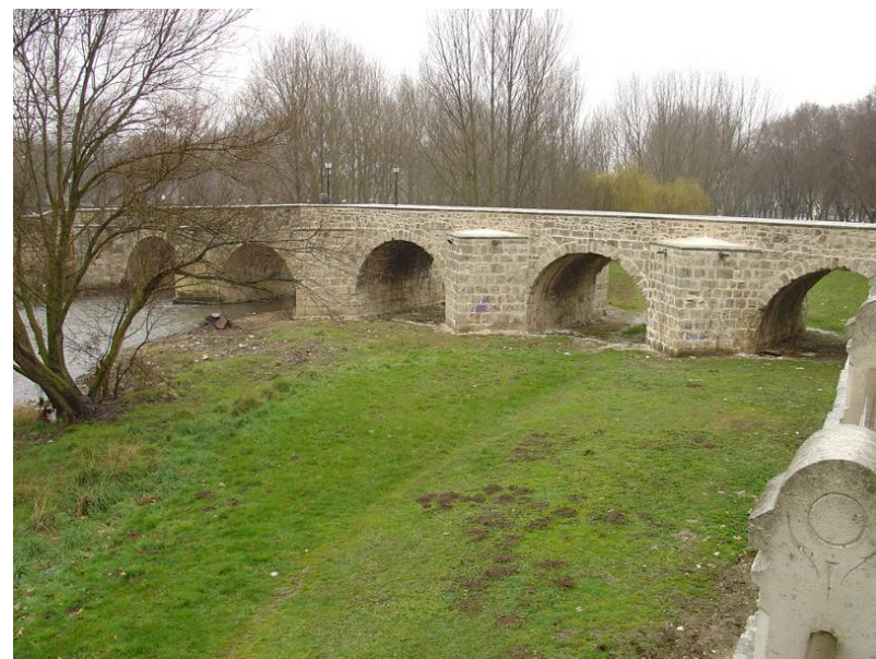
Puente de Malatos (Burgos)
